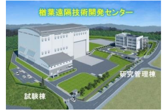
楢葉遠隔技術開発センター (モックアップラボ)
