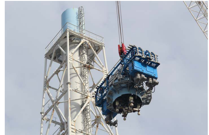
地元企業による排気筒の解体作業※
