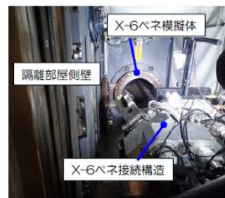
隔離部屋内作業(X-6ベネ近傍) 組合せ試験の状況
