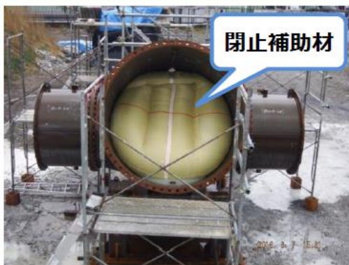
1 / 1スケール試験体で閉止補助材の止水性能を確認（屋外）
