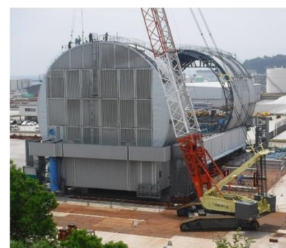
3号機 燃料取り出し設置訓練の状況 ドーム屋根ユニット組立
