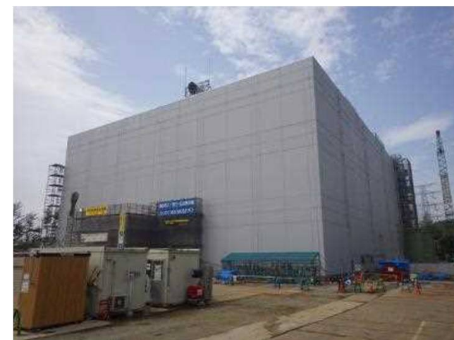
雑固体廃棄物焼却設備（建屋全景）
